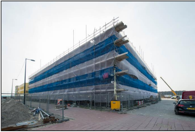
Buitenkant schoolgebouw in de steigers.
